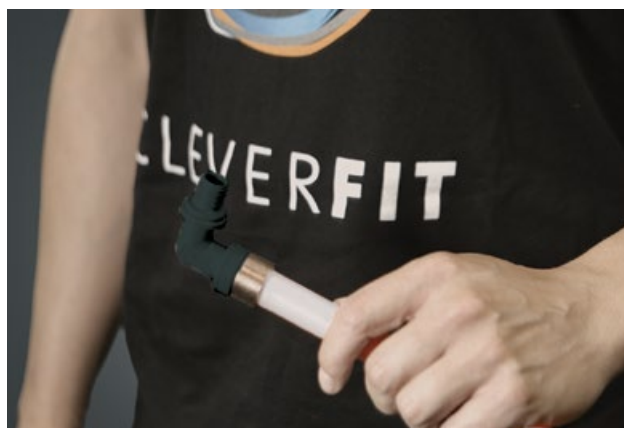
Inelul este sertizat peste fitting - conexiunea este gata
