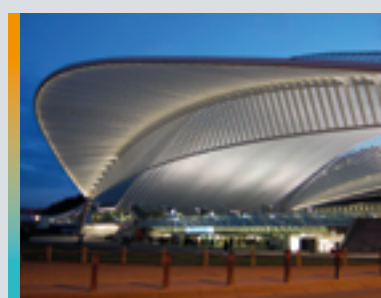
Station / Gare Luik / Liège Guillemins (BE)
