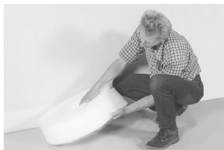
Randdämmstreifen mit seitlicher Folienschürze auslegen,
