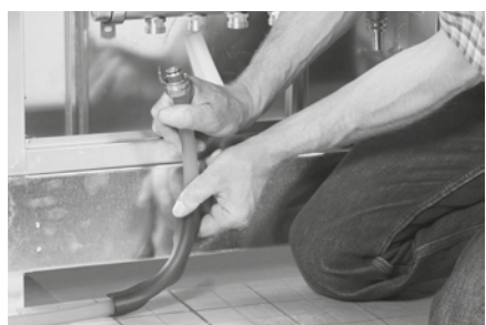
Heizrohr am Verteiler anbringen, fertig!
