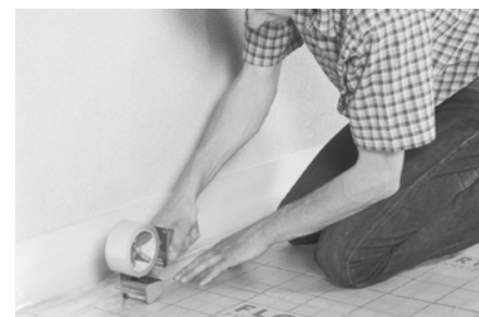
Randdämmstreifen (beim Einsatz von Fließestrich) abkleben.
