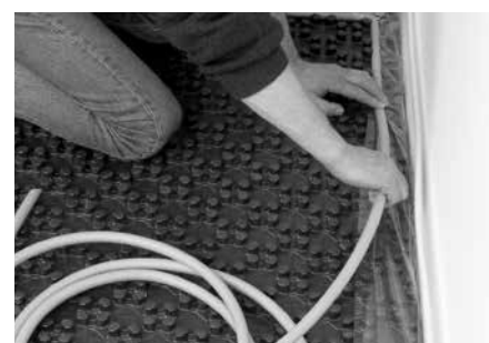
Abb. 2: Fixierung des Foliestreifens
