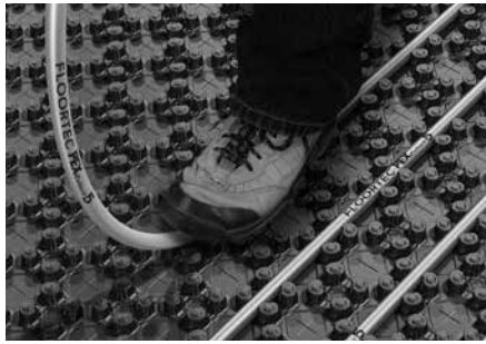
Abb. 1: Pe-Xcellent 5 Fußbodenheizungsrohr Verlegung
