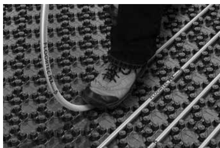
Schnelle und saubere Verlegung durch Überlappungstechnik.
