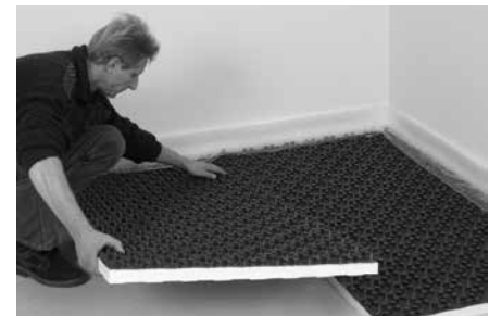
FLOORTEC System-Noppenplatten auslegen.
