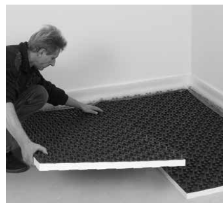
Abb. 1: Verlegung von Systemelementen
