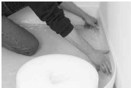
Randdämmstreifen mit seitlicher Folienschürze auslegen.
