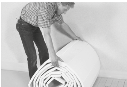
Tackersystemelemente auslegen und ausrollen.
