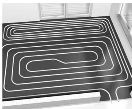
Abb. 3: schneckenförmige Verlegung mit integrierter Randzone
