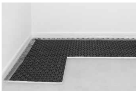
Mit dem abgeschnittenen Elementteil nächste Verlegereihe beginnen.
