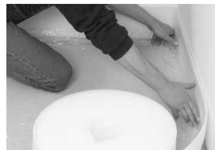
Abb. 1: Randdämmstreifen mit Foliestreifen
