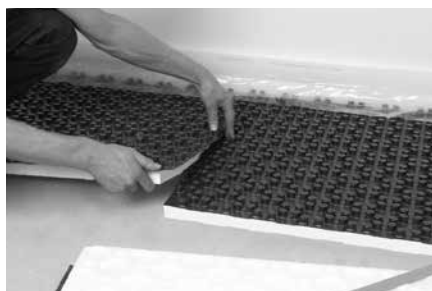
Schnelle und saubere Verlegung durch Überlappungstechnik.
